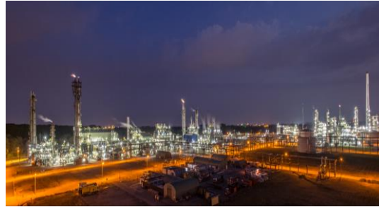
Chemelot Industriële site
