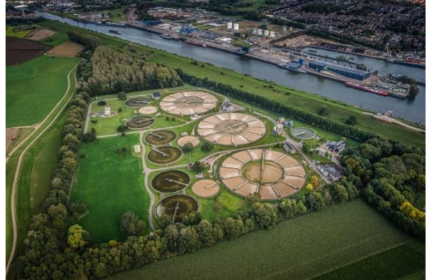
Industriële Afvalwater Zuivering Installatie
